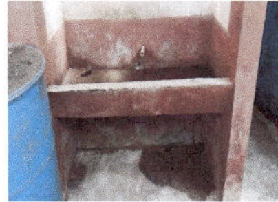
Foto 8: sustrucción de llave de chorro y azulejo en lavamanos
