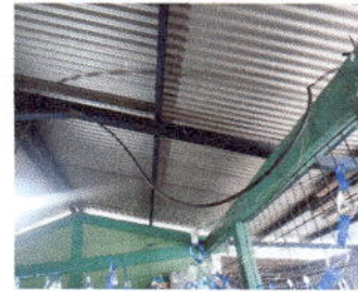
Foto 10. Reparación del cableado eléctrico
