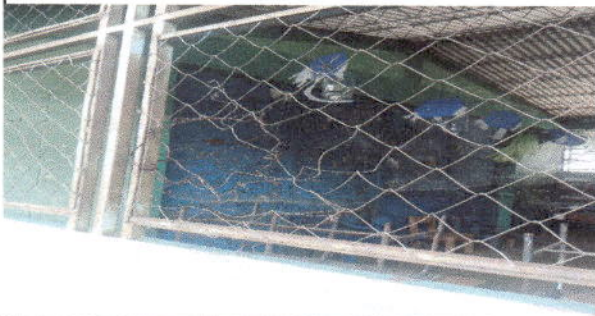
Foto 3: Mantenimiento de estructura de metal de ventanas
