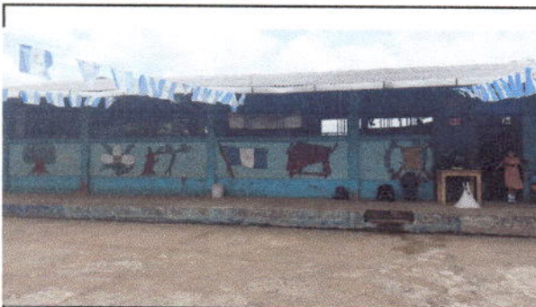
Foto 5. Pintura en muros exteriores e interiores
