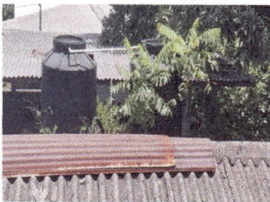
Foto 11. Sustrucción de depósito de agua.
