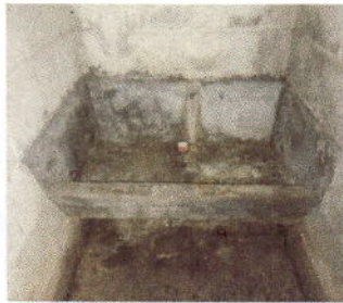
Foto 7. Sustrucción de llave de mingitorio y colocación de azulejo
