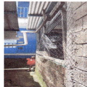
Foto 12. Repello de pared y fabricación e instalación de ventanas de metal
