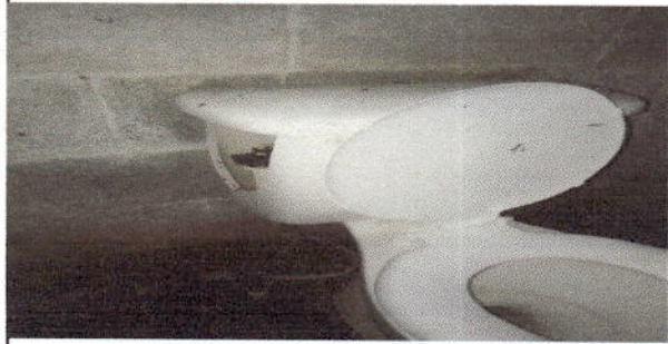
Foto 6. Sustitución de inodoro.
